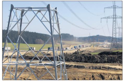
An Herausforderungen mangelt es nicht: Bei Derching muss die 380-kV-Leitung verlegt werden. Zahlreiche Über- und Unterführungen werden neu gebaut. Übrigens: Keinerlei Material wird abgefahren. Der alte Asphalt wird abgefräst, die darunter liegende Betondecke aus der Bauphase der A 8 wird gebrochen und wieder in den Untergrund eingebaut. Fotos: Edler
