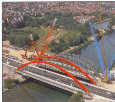
Bau der Lechbrücke
