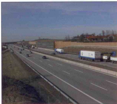
Lärmschutzwand bei Palsweis
