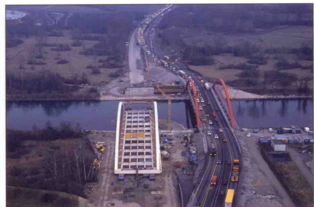
Neubau der Lechbrücke
