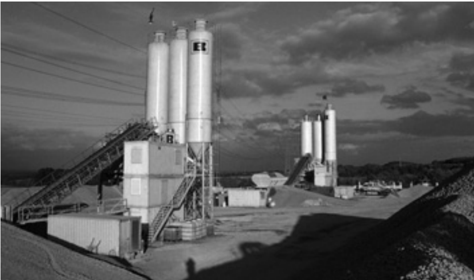
Mobile Betonmischanlagen an der Anschlussstelle Dasing
