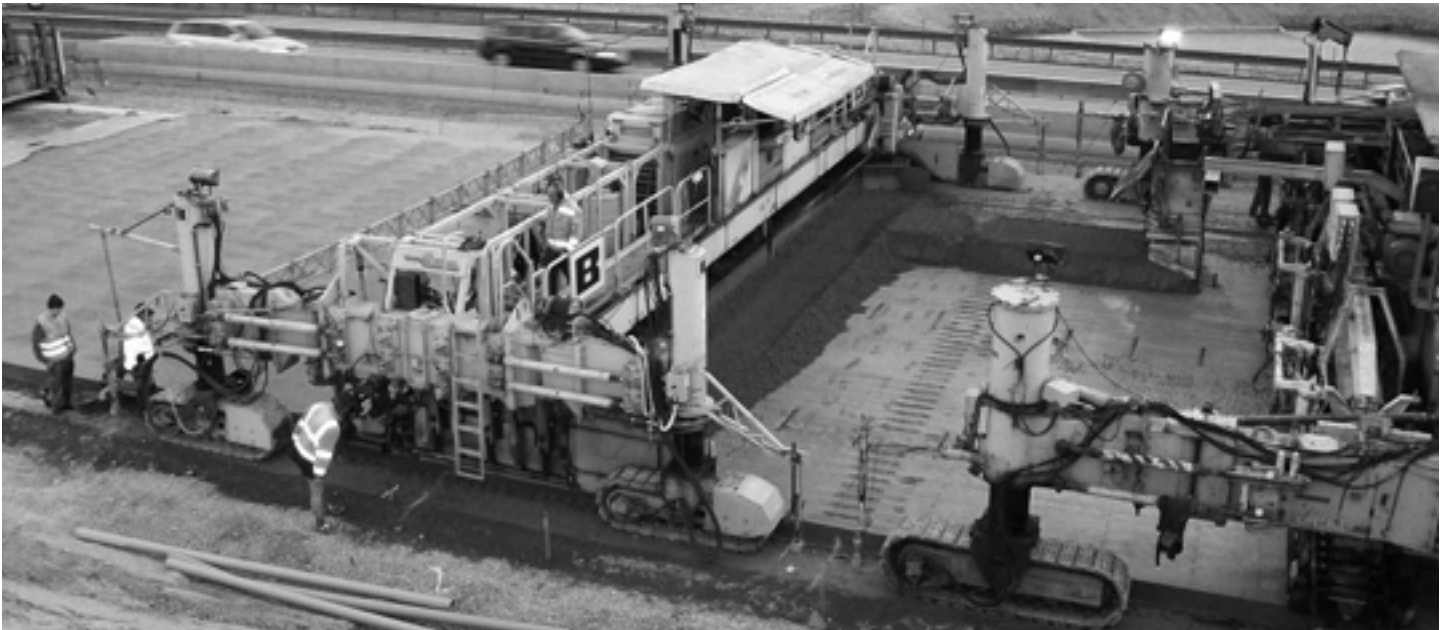
Betoneinbau mit Beschickung und Vorverteilung
