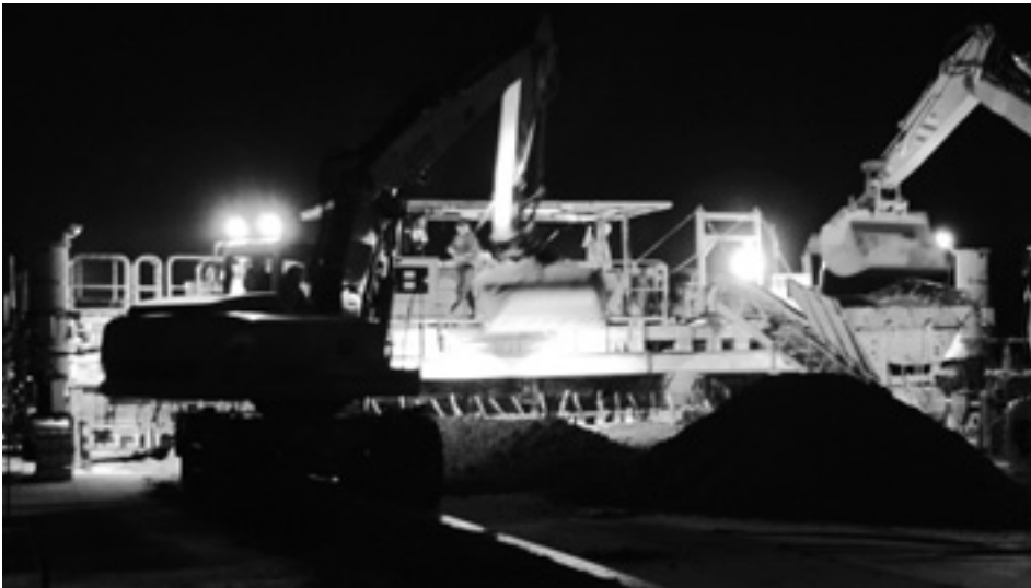
Betoneinbau bei Nacht
