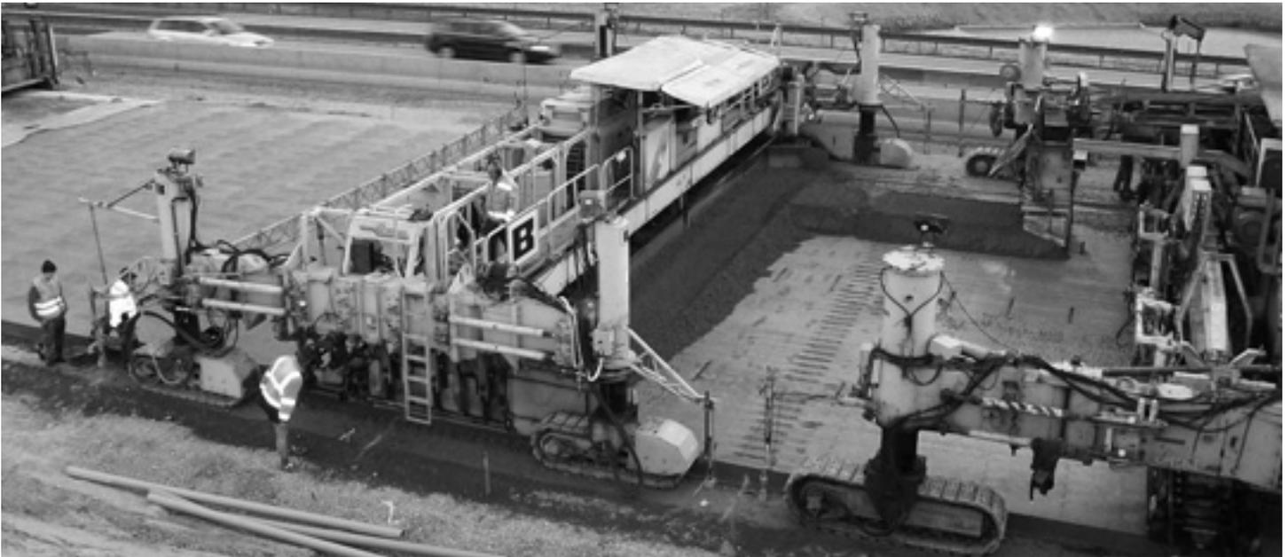
Betoneinbau mit Beschickung und Vorverteilung
