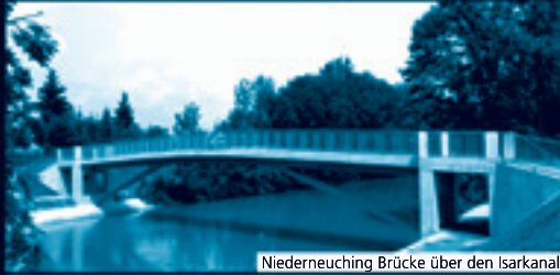
Niederneuching Brücke über den Isarkanal
