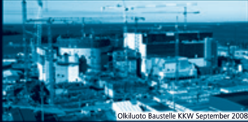
Olkiluoto Baustelle KKW September 2008
